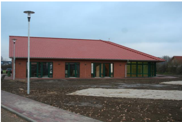
Endlich fertig: Neues Krippen- und KiGa-Gebäude)
